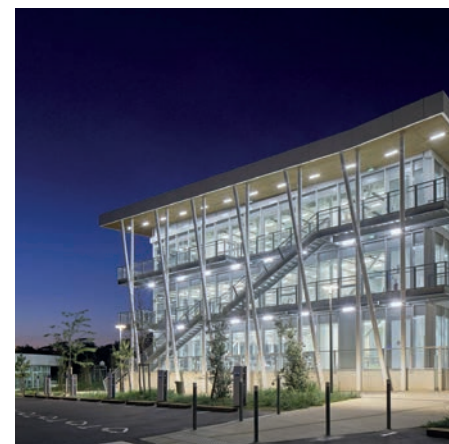
Le Square - IMMA Technologie - Architecte AA
