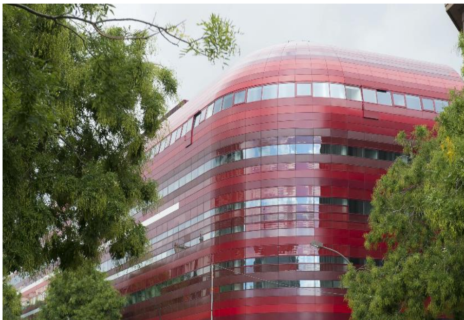
Vue extérieur, Centre-Bus de Lagny, Brigitte Métra.
